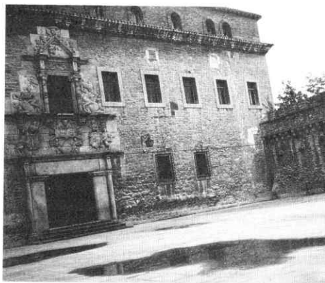
Palacio Escoriaga-Esquivel, una de las obras emblemáticas del siglo XVI en Vitoria.
