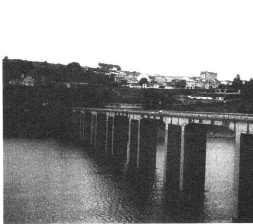
Viaducto sobre el embalse de Belesar.
