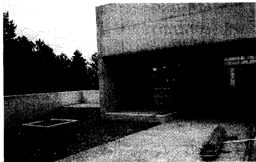
Pórtico Superior aún en construcción.
